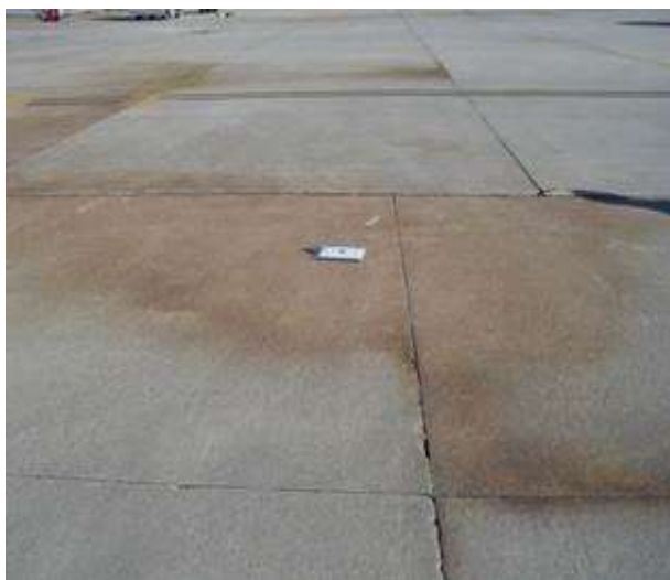
Figura 2.19 – Bombagem de finos (Pavement Interactive@ 2016)
