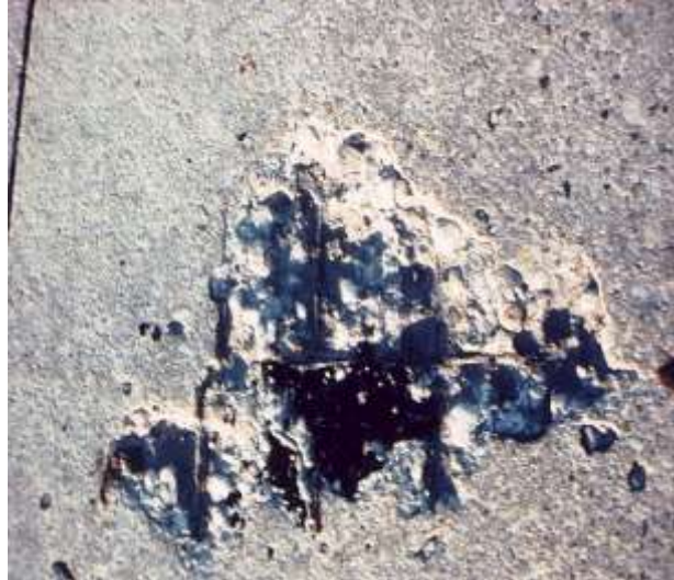
Figura 2.17 – Pequenos pedaços do pavimento (Pavement Interactive @2016)
