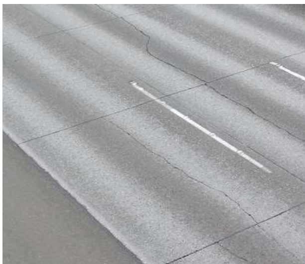
Figura 2.8 – Fendilhamento longitudinal (Pavement Interactive @2016)
