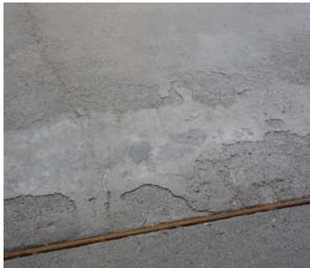
Figura 2.14 – Lasqueamento da junta (Contractor Talk@2016)
