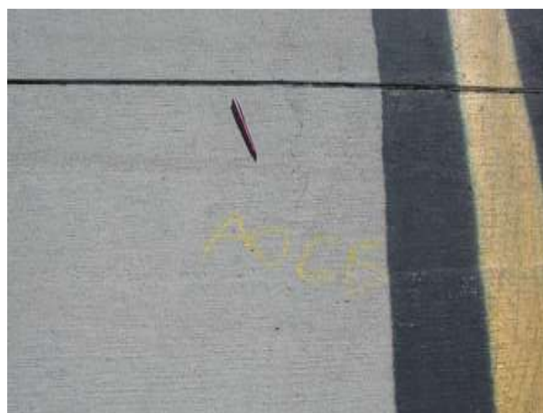
Figura 2.27 – Fendas de retração (FAA, 2009)
