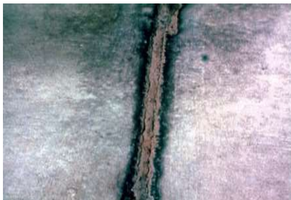
Figura 2.34 – Bombagem de finos (FAA, 2009)
