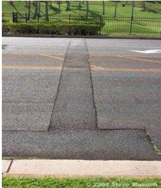
Figura 2.22 – Remendagem da laje (Pavement Interactive @2016)
