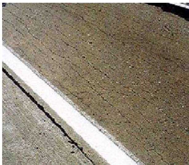
Figura 2.23 – Reação Alkali-Sílica (Pavement Interactive @2016)
