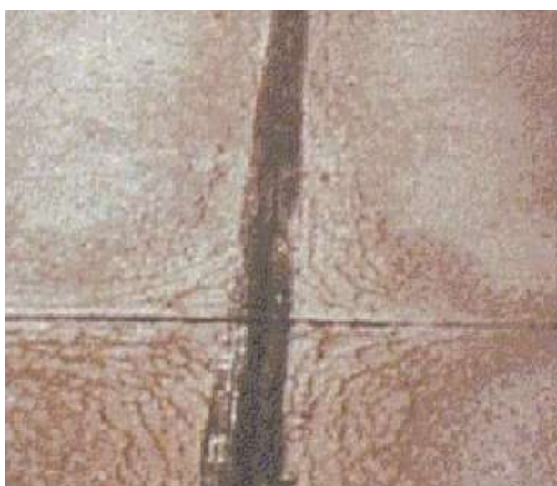
Figura 2.9 – Fendilhamento de durabilidade (Pavement Interactive @2016)
